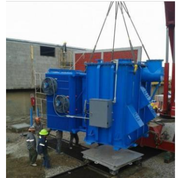
2 Transformadores de Potencia de 7.5 MVA EN 115 a 13.8 kV
