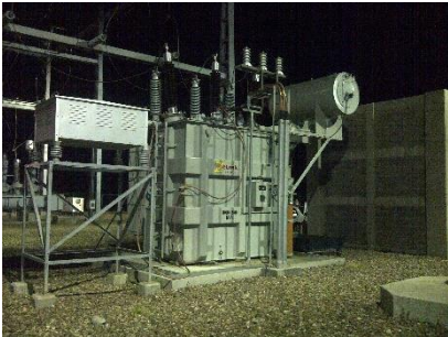
Transformador de Potencia de 10 MVA
