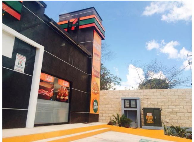
7 Transformadores tipo pedestal de 45 y 75 kVA
