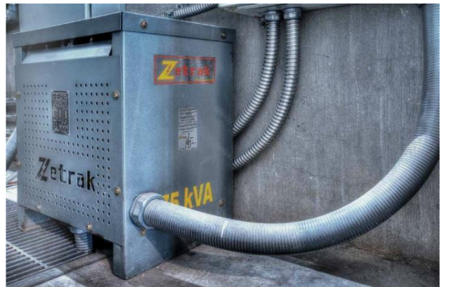
11 Transformadores tipo seco de baja tensión en diferentes capacidades
