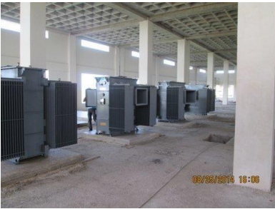
22 Transformadores tipo pedestal y subestación de diferentes capacidades
