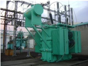
Reparación de transformador de Potencia de 24/32 MVA
