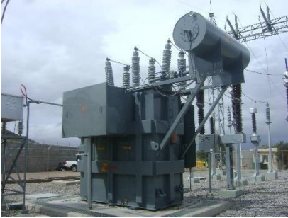
Transformador de Potencia de 7.5 MVA en 115 a 13.8 kV
