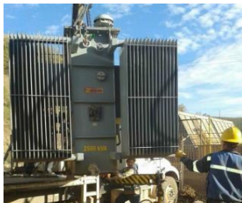
Transformador de Potencia de 5 MVA.
