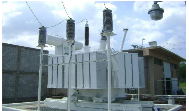
Reparación de transformador de Potencia de 10/12 MVA
