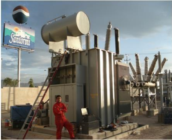
Transformador de Potencia de 7.5 MVA
