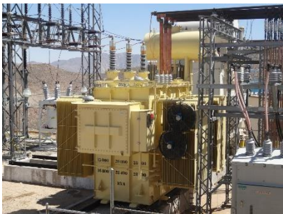
Transformador de Potencia de 15, 20, 25, 28 MVA con L.T.C. en Alta Tensión
