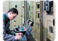
ProSelect, Diagnóstico de la unidad de disparo de un interruptor en aire en BT.
