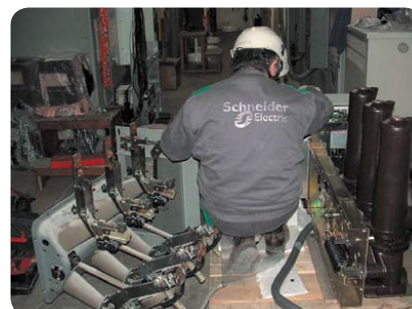
ECOFIT de un interruptor en MT.
