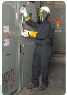
Equipo de Protección Personal, Nivel 2, determinado con estudio de Arc Flash.
