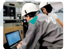
ProDiag, Diagnóstico del funcionamiento de un interruptor de potencia en MT.
