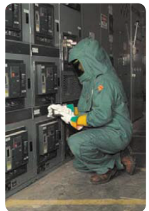
Equipo de Protección Personal, Nivel 4, determinado con estudio de Arc Flash.
