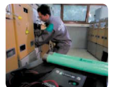
ProFusion, Diagnóstico del funcionamiento de fusibles de MT
