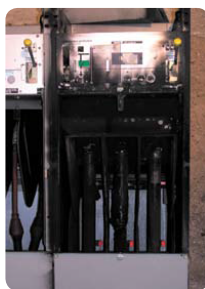
Evite los contratiempos por equipos obsoletos y poco con ables
