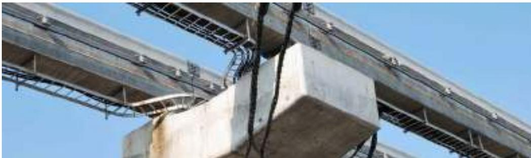
Se considera un **Sistema de Soporte Para Cable (SSPC) o Charola** a una estructura rígida y continua, especialmente construida para **soportar cables, tubos u otras canalizaciones**, las cuales pueden ser de **metal** u otros **materiales no combustibles**.
