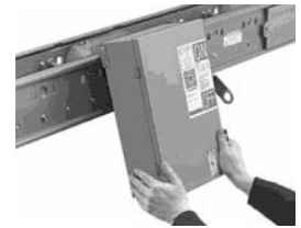
Montaje de unidad de enchufar
