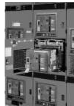
Interruptor NW removido en PZ4
