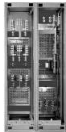
PZ4 Vista posterior compartimento de cables
